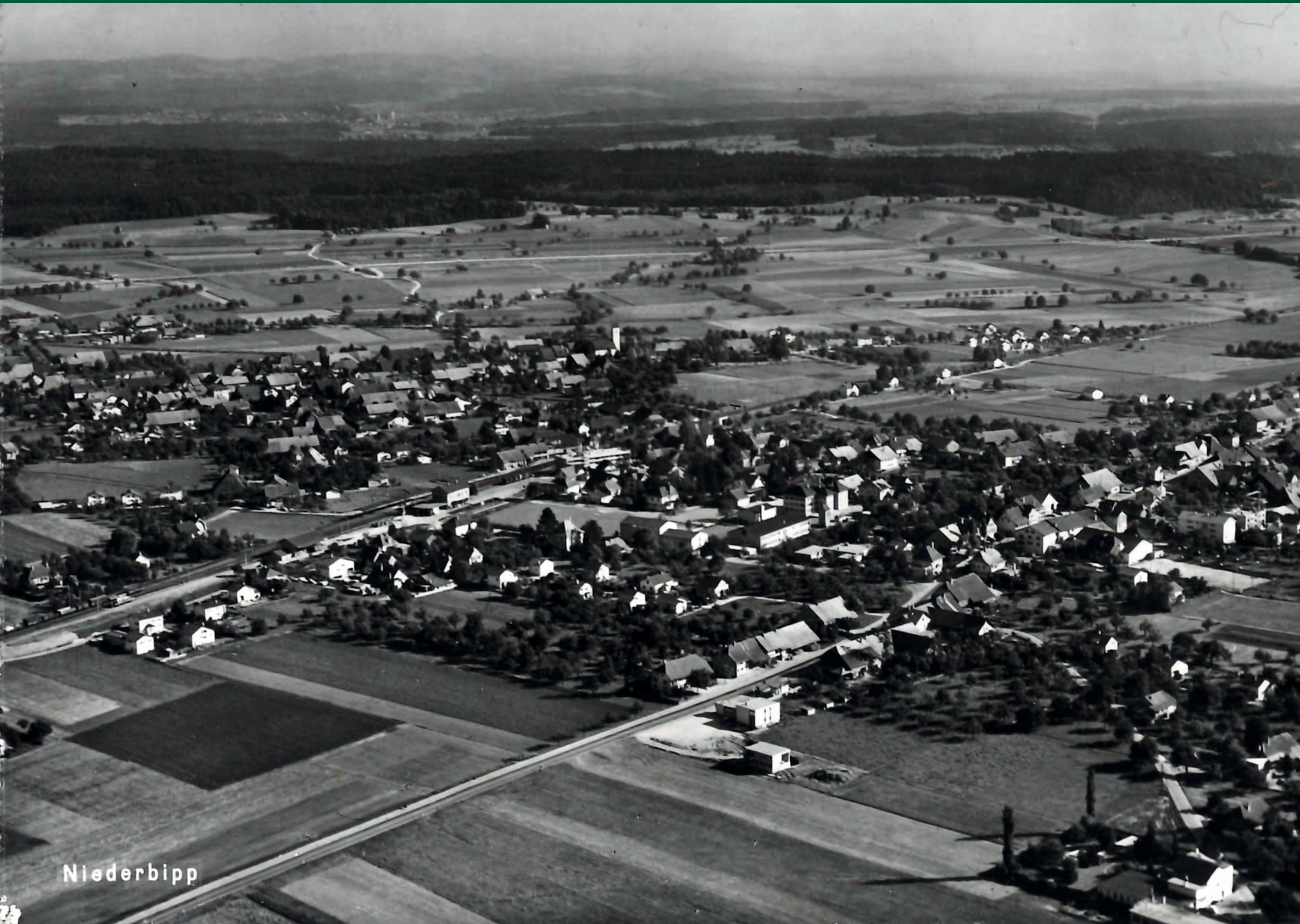
Blick von Nordosten um 1960
